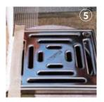
In die LEWIS®-Schwalbenschwanzplatte wird eine Aussparung geschnitten. Der Zwischenraum zwischen dem Aufstockelement und der LEWIS®-Schwalbenschwanzplatte muss abgedichtet werden. Der wasserbeständige Anschluss des Aufstockelements an den Betonfußboden wird gemäß unserem Hinweis "Wasserbeständige Ausführung" und den Herstellerrichtlinien hergestellt.
